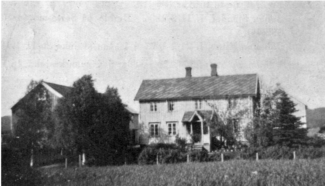
Systua i Myran, Snekkerverkstedet skimtes bak trærne til høyre
